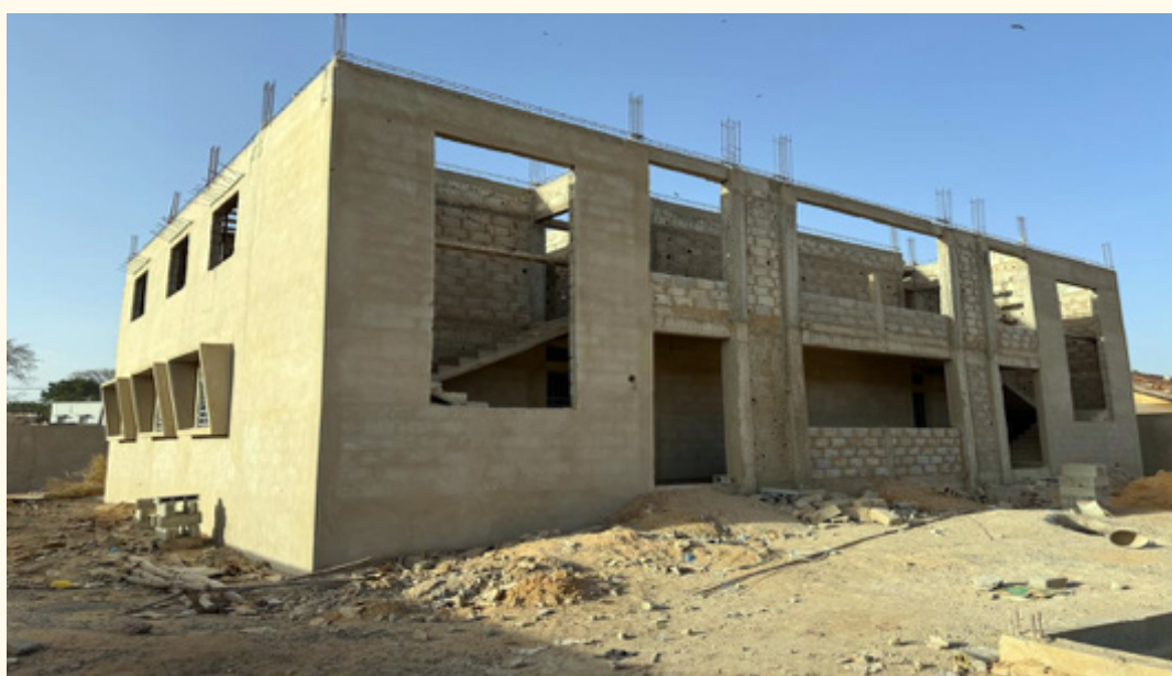
Construction d'une garderie pour les enfants du personnel de la Police nationale du Sénégal, Thiès (Sénégal), décembre 2025
