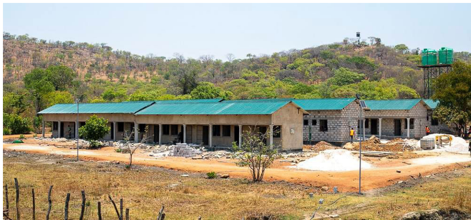
Construction d'un bâtiment d'hébergement de 40 lits et d'une garderie destinée aux policières, Zambie, 2025.
